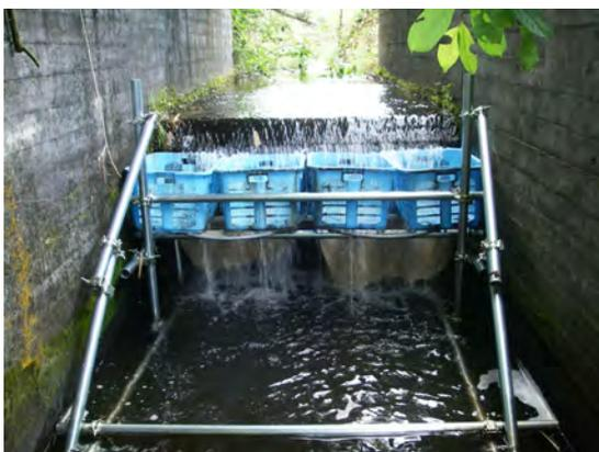
設置した流出防止用カゴの例。ゴミによる目詰りが少なく、メンテナンスがラク。
